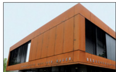
Bild 2: Fassadenplatten aus wetterfestem Baustahl
