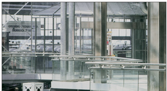
Bild 1: Geschäftsgalerie mit Geländern, Trägern, Stützen und Verkleidungen aus nichtrostendem Stahl
